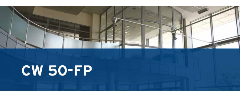
CW 50-FP El30 offre un laps de temps ignifuge de 30 minutes qui est obtenu par le placement de gaines en acier dans les profilés et étendu et par l'utilisation des joints gonflants ignifuges. Avec CW 50-FP El60 le laps de temps de 30 minutes jusqu'à 60 minutes par l'addition d'un élément de réfrigération. Du fait même que les 2 versions du CW 50-FP sont visuellement identiques au CW 50, elles peuvent être utilisées en parallèle à la gamme CW 50.
